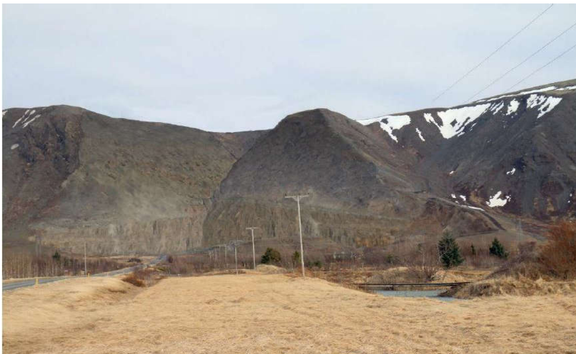
Mynd 1. Þórustaðanáma séð frá heimreið að Þórustöðum eftir að efnistöku lýkur. Ætlunin er að hallinn á hlíðinni verði sambærilegur og í Djúpadal sem er til hægri á myndinni (Byggt á matsskýrslu).
