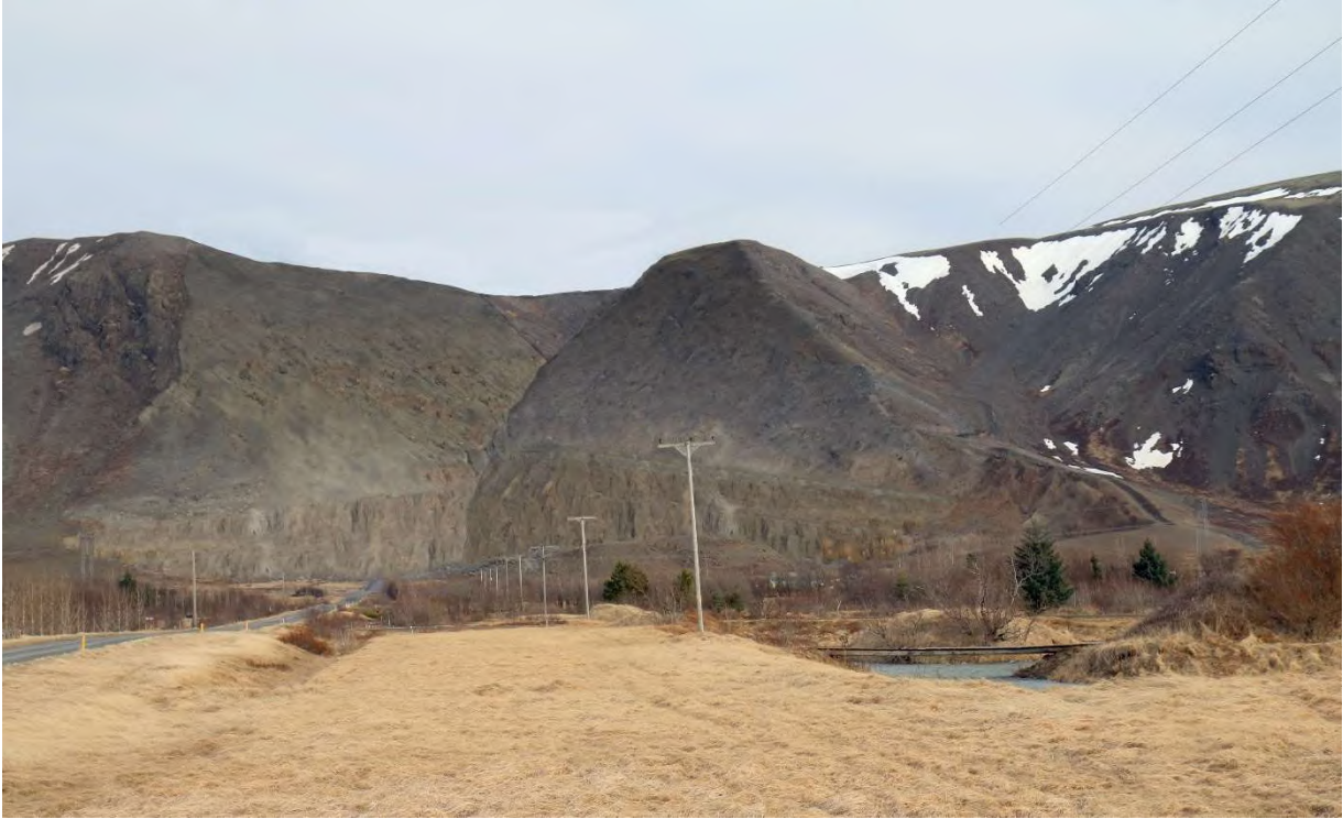
MYND 4.9 Þórstaðanáma séð frá heimreið að Þórstöðum eftir að efnistöku lýkur. Ætlunin er að hallinn á hlíðinni verði sambærilegur og í Djúpadal (til hægri á myndinni). Hlíðin mun svo veðrast og fá náttúrulegt útlit með tíð og tíma. Raskað svæði sem sést stækkar lítið sem ekkert.
