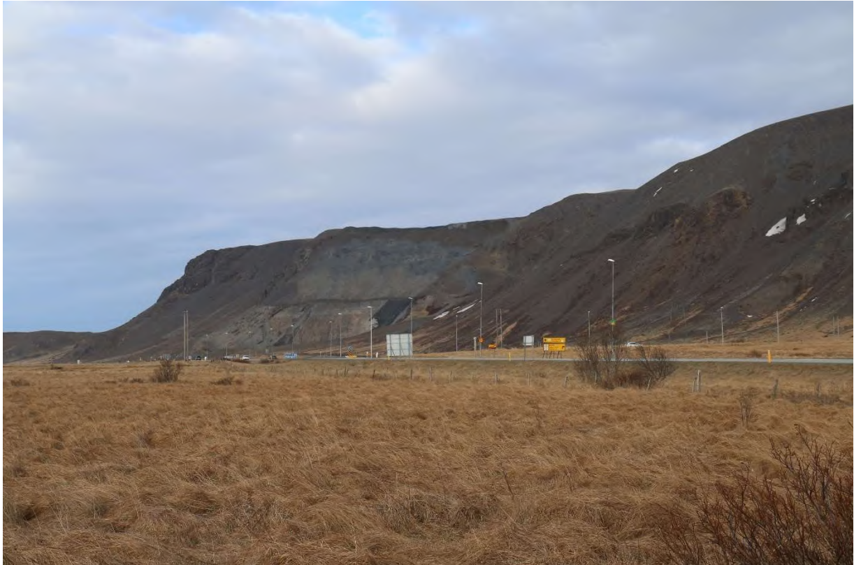
MYND 4.11 Þórustaðanáma séð frá Toyota-umboðinu þegar efnistaka er komin niður að þétta berggrunninum í botni fjallsins. Búið er að taka klettana í efri hluta fjallsins og er stallur rétt fyrir neðan miðjar hlíðar sem efni er ýtt fram af.
