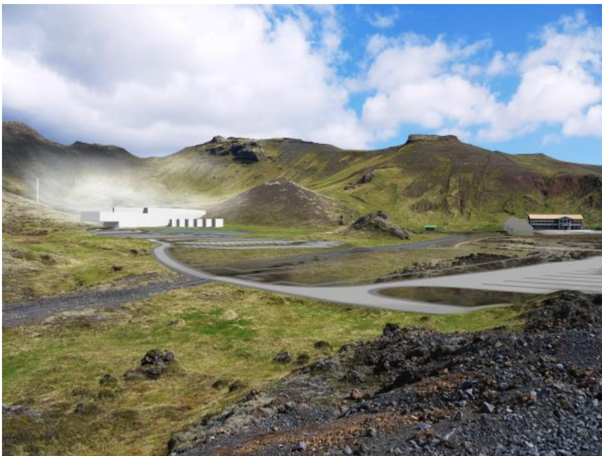
Mynd 4-1. Horft í átt að Hótel og baðhúsi og yfir settjarnir.
